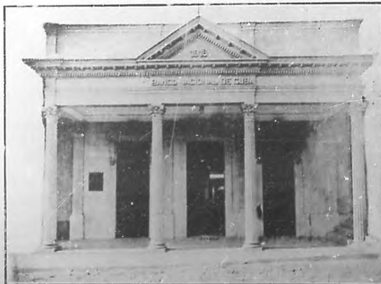
La nueva Sucursal del Banco Nacional de Cuba en San Luis, Oriente.— Fachada del hermoso edificio inaugurado en el mes de Julio último.
